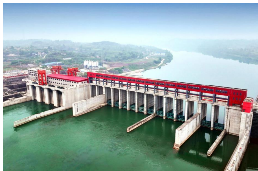
重庆利泽航运枢纽一期工程
