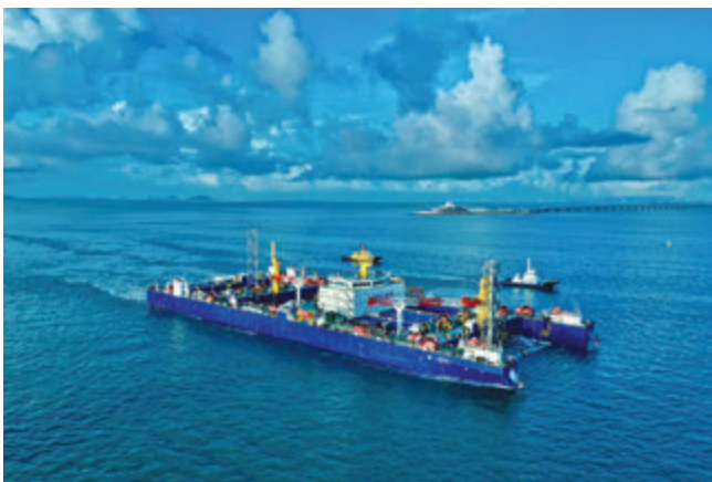
沉管运输安装一体船“一航津安 1”途径港珠澳大桥
