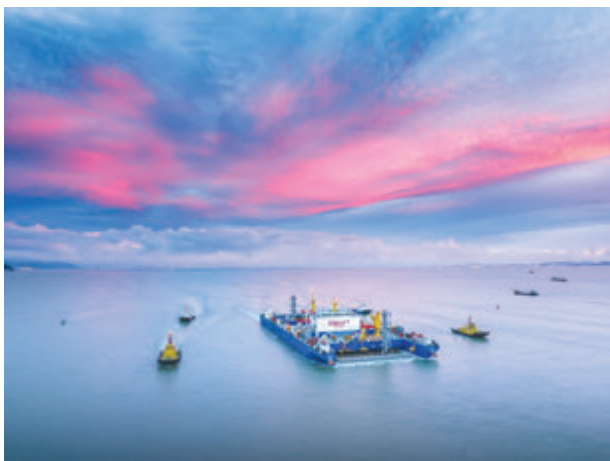
航行中的沉管运输安装一体船
