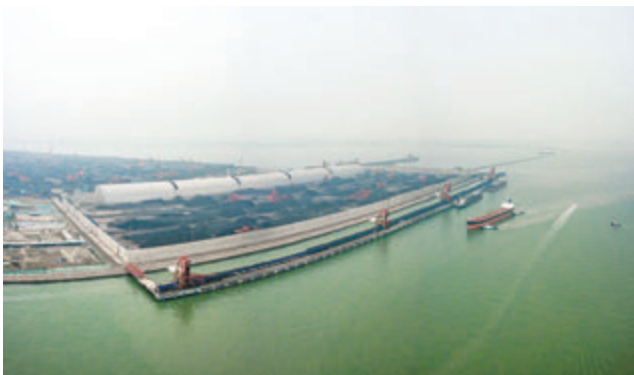
华能唐山港曹妃甸港区煤码头条形料仓
