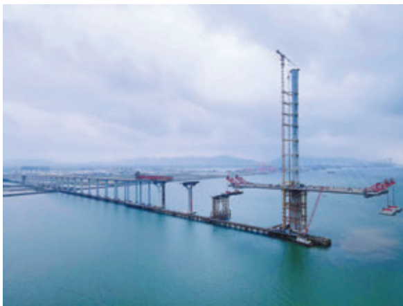
建设中的黄茅海项目
