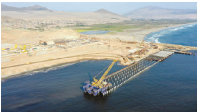
项目智能打桩平台正在施工航拍图
