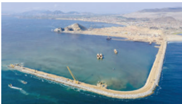
项目 ZOP 区施工现场全景航拍图
