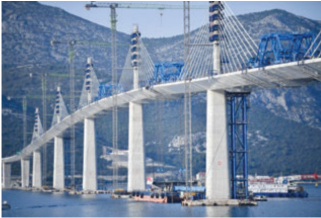
克罗地亚佩列沙茨大桥施工现场
