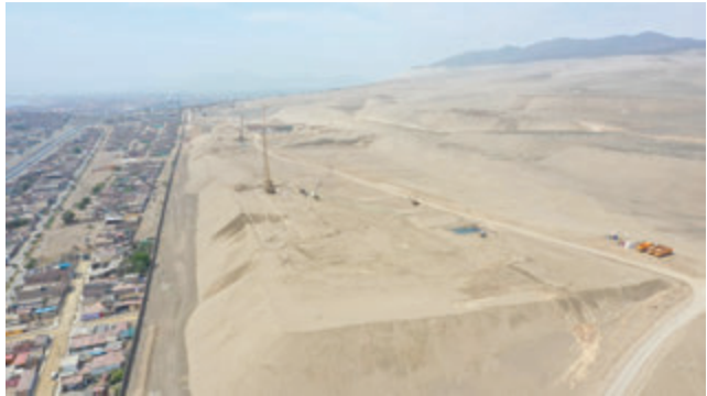
项目 CI 区施工现场全景航拍图
