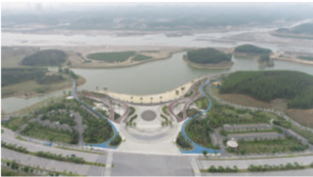
已建成的孔雀湾内湖外海滨海公园航拍图
