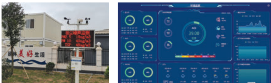
场站位置配备扬尘噪声监测
