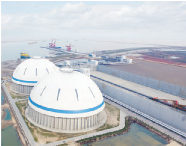
盐城港滨海港区煤炭码头穹顶圆形料仓
