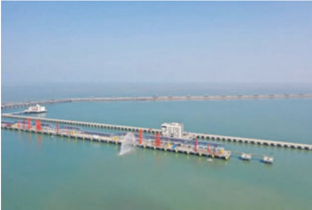
中国首个全装配式高桩码头： 连云港港徐圩港区 64 至 65 号泊位
