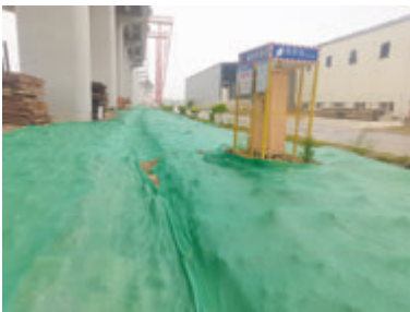
使用覆盖绿网防止扬尘
